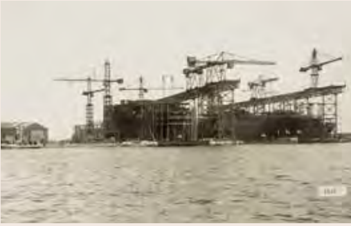
▲ Gezicht op de nieuwe scheepswerf van de Nederlandse Scheepsbouw Maatschappij in Amsterdam in 1928. Op de kraanbanen rijden torenkranen. Links staan de eerste torenkranen die over de kade reden (bron: Stadsarchief Amsterdam).
