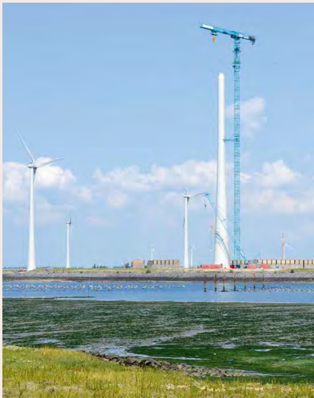
▲ Nieuwe landschapselementen: een bouwkraan bij het windmolenpark Krammer, 2018 (foto: Geert de Weger).
